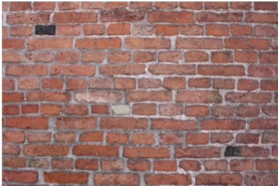
Abbildung 8: Historisches Sichtmauerwerk aus Ziegelmauersteinen im Mauerwerksverband
