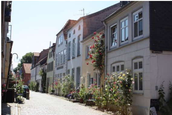
Abbildung 3: Kleinteilige Gebäudestruktur in der Fischerstraße (Fischerquartier)
