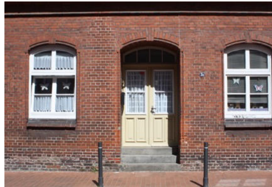
Abbildung 9: Historische Außenwandfläche aus Sichtmauerwerk
