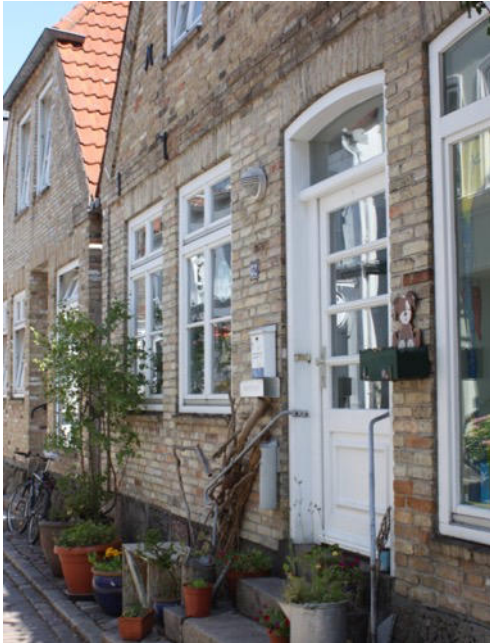
Abbildung 10: Historische Außenwandfläche mit gelb-ockernem Farbton
