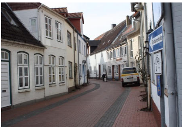
Abbildung 12: Helle Putzfassaden am Taterberg
