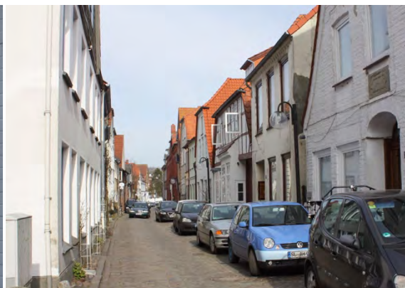
Abbildung 13: Helle geschlammte und verputzte Fassaden in der Fischerstraße
