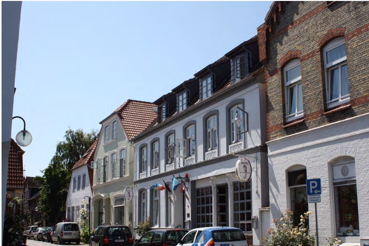
Abbildung 21: Historische Häuser in der Fischerstraße ohne Dachüberstand
